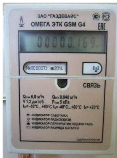
Рисунок 2 – Табличка счетчика газа
